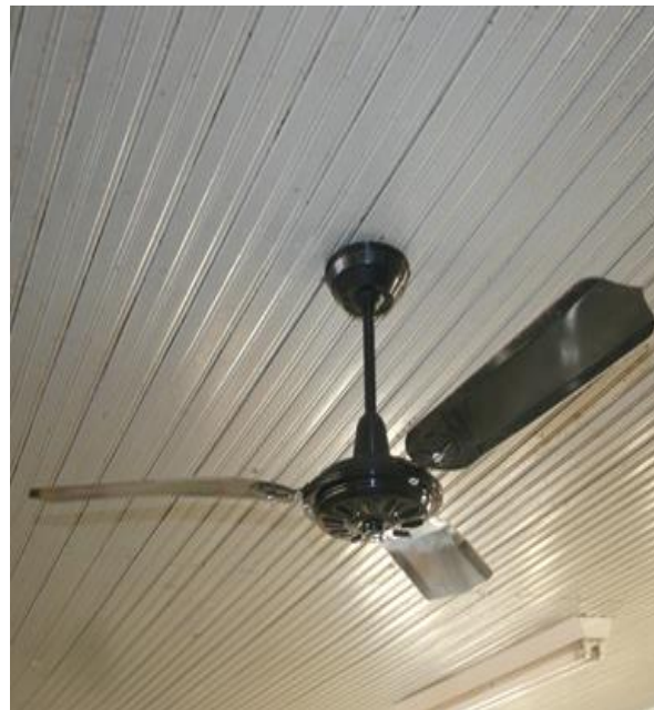
Detalhe: ventilador de teto
