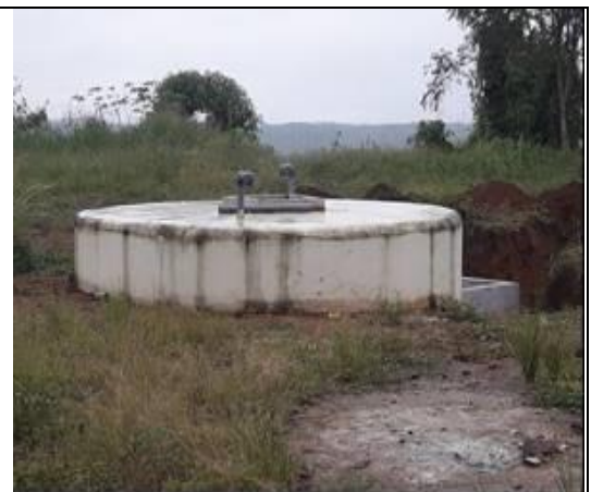
TANQUE DE DISTRIBUCION
