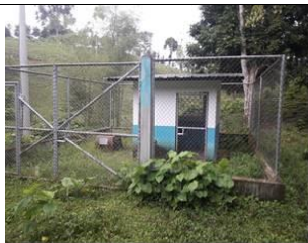
POZO DE EXTRACCION DE AGUA CON CASETA
